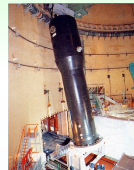
(蒸気発生器の取替え)
