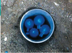
地中熱探熱管挿入完了状況
