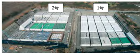
日本原燃（株）六ヶ所低レベル放射性廃棄物埋設センター
