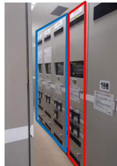
放射線監視装置信号処理盤
