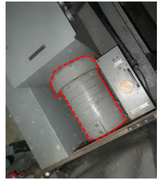
高感度型主蒸気管モニタ
