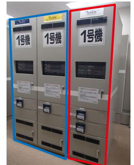
放射線監視装置信号処理盤
