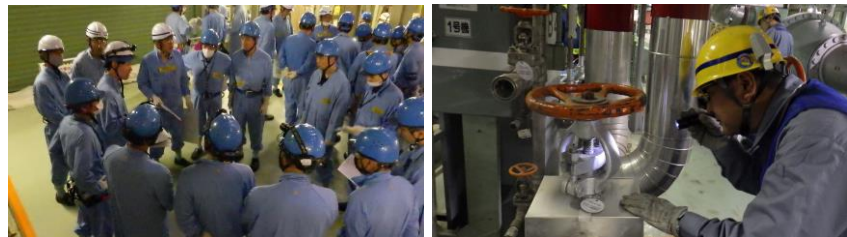
左：点検開始前のミーティング、 右：弁の漏洩確認
