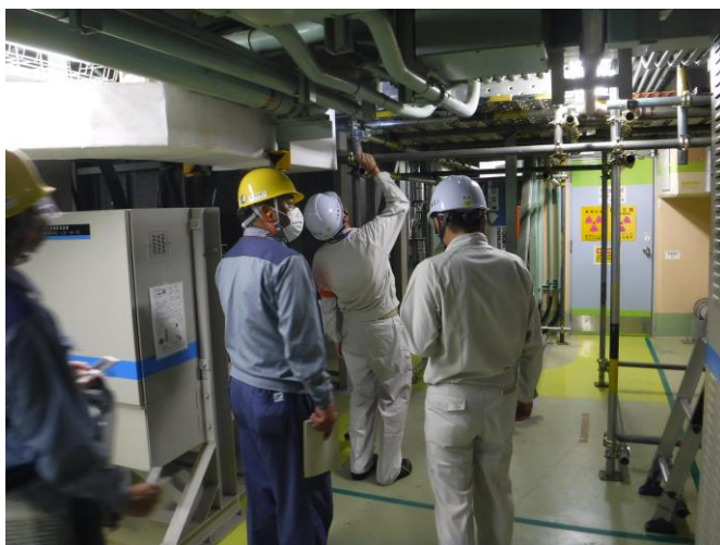
工所用仮設足場の設置状況の確認
