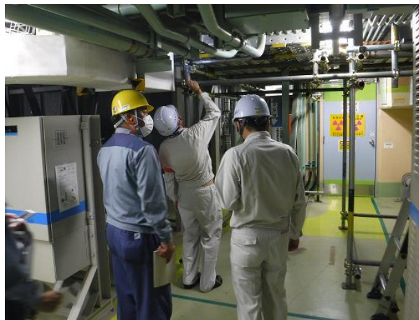
工事用仮設足場の設置状況の確認
