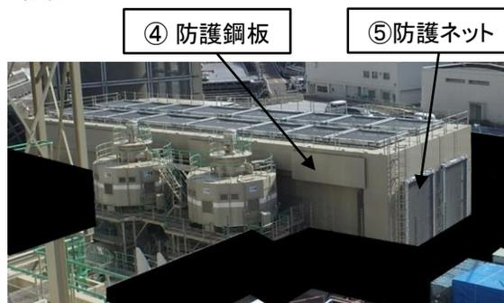
図-12 重大事故への対策(電源の確保:交流電源)
