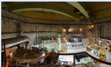
見学（原子炉格納容器内部）
