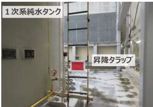
重要機器付近で実施する工事例 (美浜3号機 1次系純水タンク昇降タラップ修繕工事)
