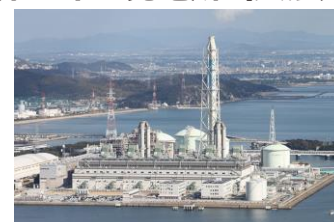
姫路第二発電所（天然ガス）
