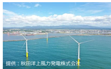
秋田港洋上風力発電所
