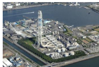
姫路第一発電所（天然ガス）
