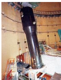
▲蒸気発生器の取替え
