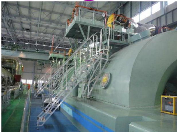
安全パトロールの気付きを踏まえた設備対策例 転落防止のため、手すり付き階段を設置
