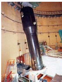
▲蒸気発生器の取替え
