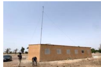
学校に設置した通信アンテナ
