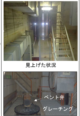
循環水管エリアの状況
