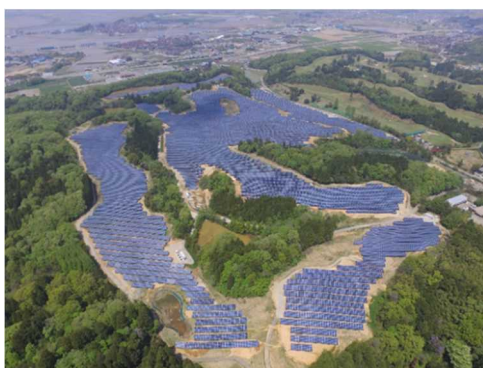
小松太陽光発電所
