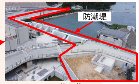
施工後 (T.P. ※2+5.5~6.0m)
