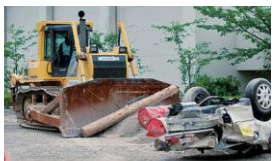
瓦礫を撤去するドーザー・ショベルを使った訓練
