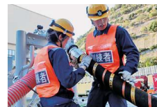
原子炉に冷却水を注入するためのポンプの設置訓練
