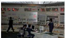
すべての電源を失った事態を想定したシミュレーターによる対応訓練
