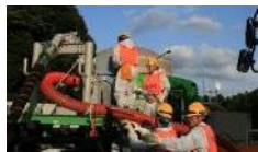
可搬式代替低圧注水ポンプ設置訓練
