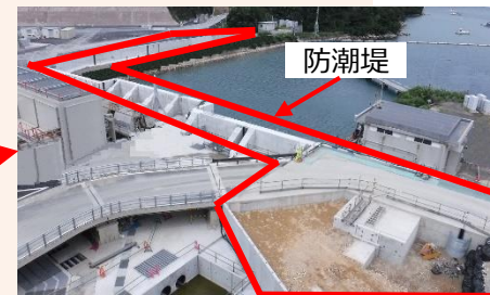
施工後 (T.P. ※2+5.5~6.0m)
