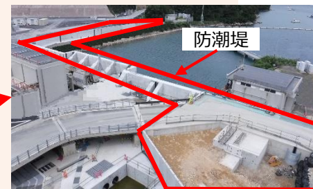
施工後 (T.P. ※2+5.5~6.0m)
