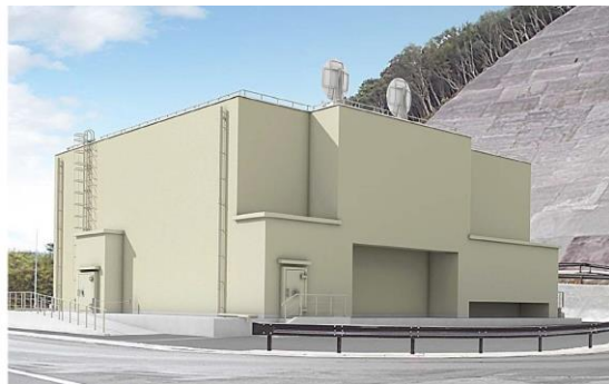
緊急時対策所（全景）
