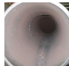
SGブローダウンタンク付近の配管内部の状況
