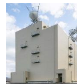
④免震事務棟
