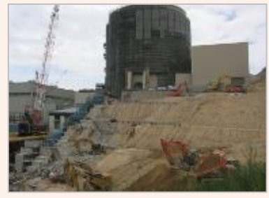
既存の地山の掘削
