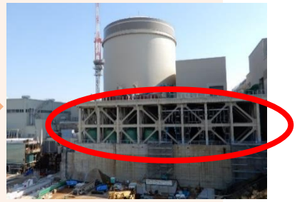
美浜発電所の構台
