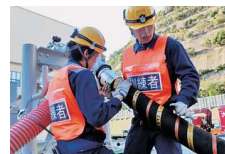
原子炉に冷却水注入するための ポンプの設置訓練
