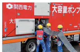
大容量ポンプ設置訓練
