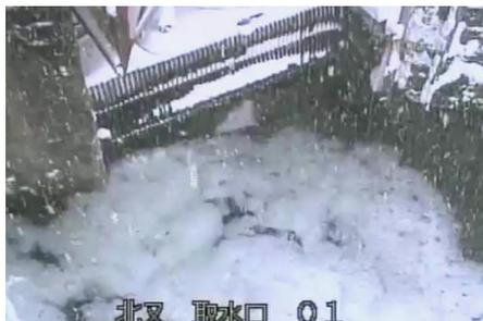
流氷雪が水門Aの上流側に設置したスクリーンまで達した場合、発電水の流れを塞ぎ、発電量が減少する。
