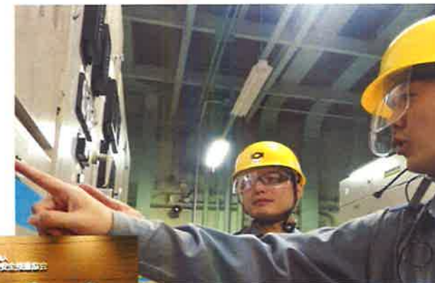
運転中の発電所で安全に作業ができるよう実務を学ぶ実機体感教育
