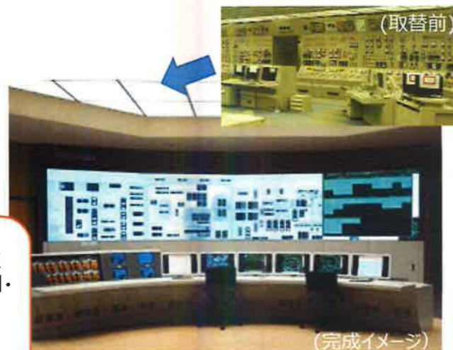
中央制御盤全体を最新のデジタル式に取替え
