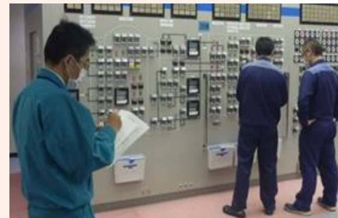
他電力社員による発電所の現場観察
