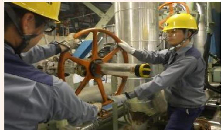
運転停止中発電所の所員による実機体感訓練
