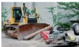
瓦礫を撤去する ドーザーショベル を使った訓練
