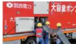
大容量ポンプ設置訓練
