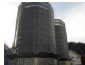
(旧タンクの仮置き状況)
