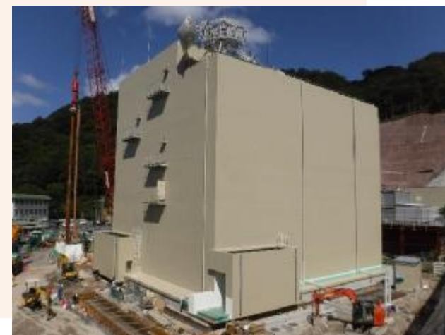
高浜発電所の免震事務棟建設
