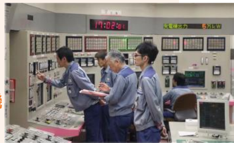
大飯4号機並列操作の様子
