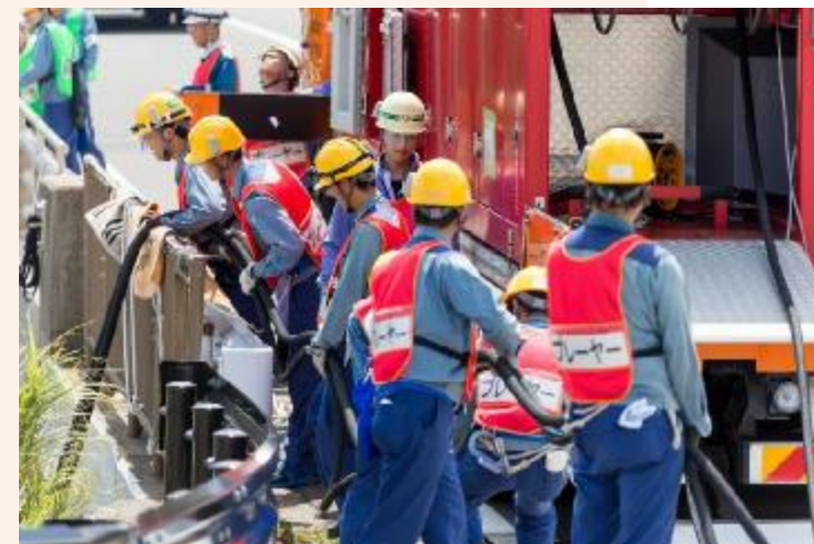
大容量ポンプの設置訓練
