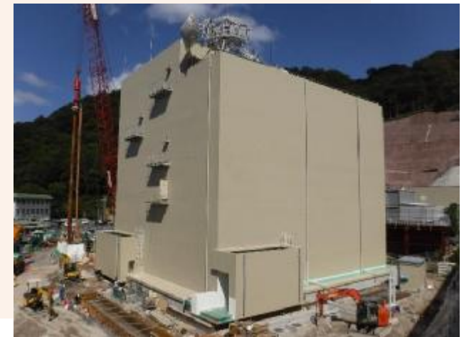
高浜発電所の免震事務棟建設
