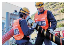
原子炉に冷却水を注入するための ポンプの設置訓練
