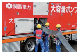
大容量ポンプ設置訓練
