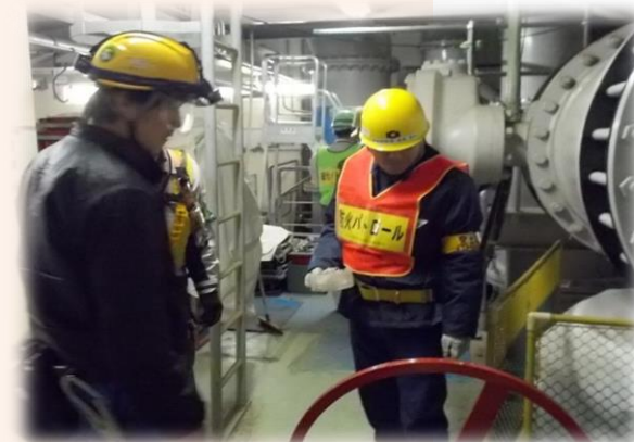
管理職による現場パトロール
