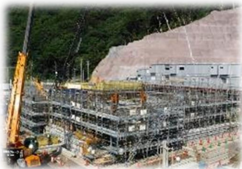
【免震事務棟基礎工事】 (高浜発電所)
