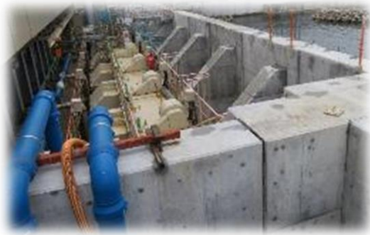
【海水ポンプ室周辺浸水防護対策工事】 (大飯発電所)
