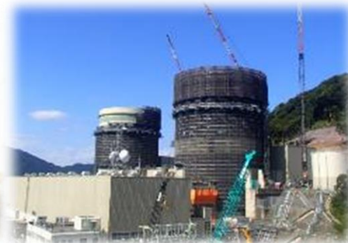
【格納容器上部遮蔽設置工事】 (高浜発電所)
