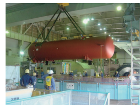
高圧給水加熱器取替え
