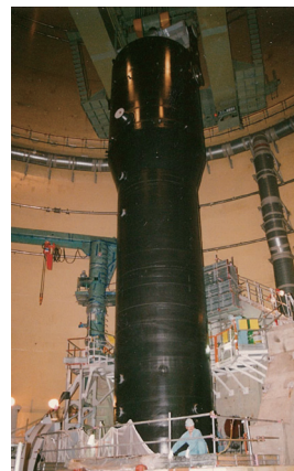
蒸気発生器取替え
