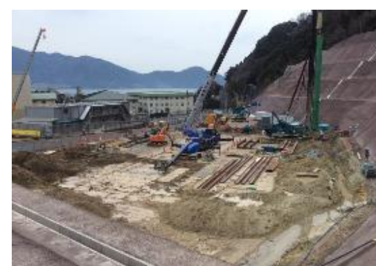
【高浜発電所緊急時対策所 建築工事】
