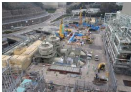
【高浜 1,2号海水ポンプ室補強工事】
