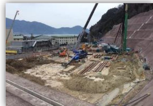
【高浜発電所緊急時対策所 建築工事】
