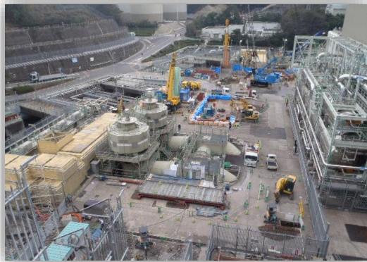
【高浜 1,2号海水ポンプ室補強工事】
