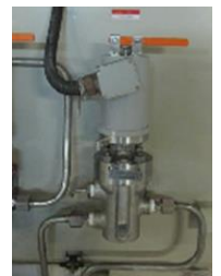
<機関停止用電磁弁の外観>
