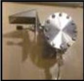
原子炉格納容器水素燃焼装置(イグナイタ)<br><b>【その他】</b><br>・原子炉下部キャビティ水位計<br>・原子炉格納容器水位計<br>・可搬型格納容器内水素ガス濃度計 等 |
