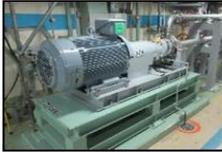
恒設代替低圧注水ポンプ<br>
