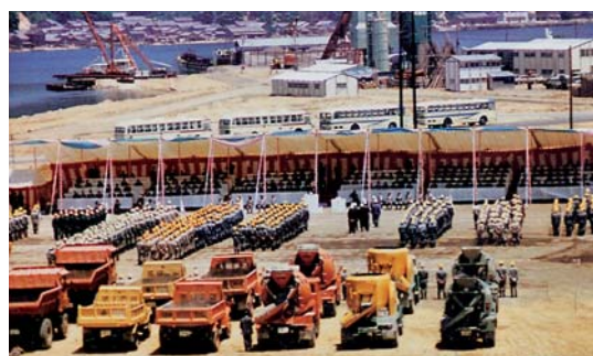
昭和42年 美浜発電所着工式の様子
