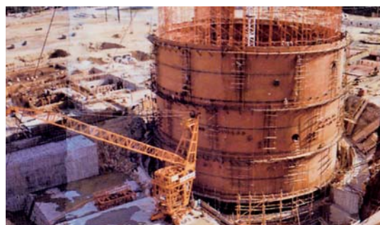
昭和42年 美浜1号機建設の様子
