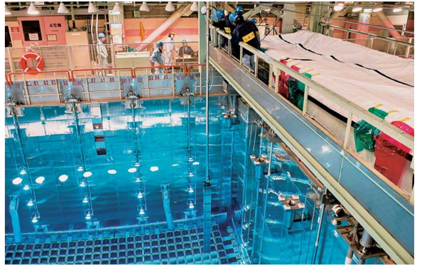
高浜4号機燃料装荷作業の様子（1月31日）
