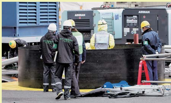
海水を貯めるための仮設組立式水槽を配置
