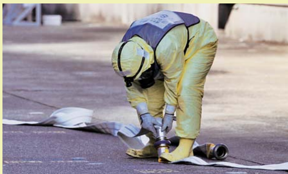
海水を送るための消防ホースを布設
