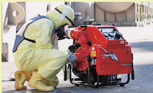
使用済燃料ピットに注水する配管につながるホースを接続
