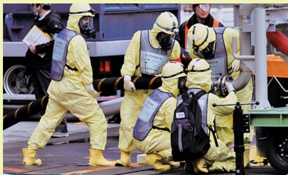
原子炉格納容器を冷却する配管につながるホースを接続
