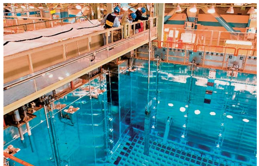
高浜3号機の燃料装荷作業の様子(12月25日)
