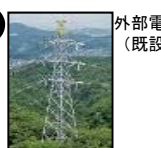
外部電源(既設)
