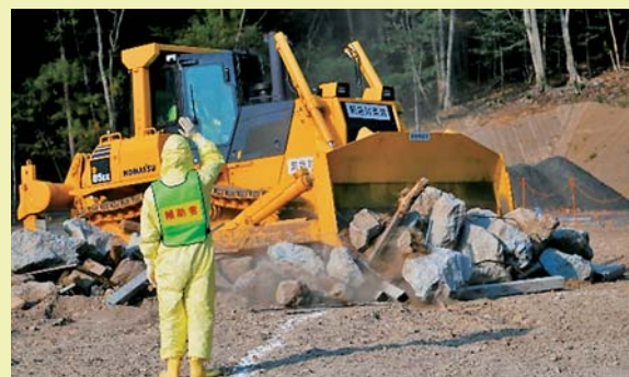
がれき撤去訓練の様子
