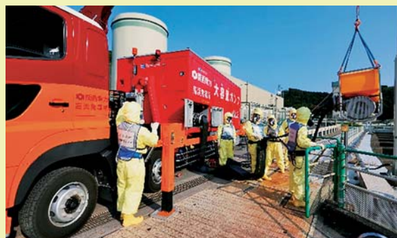
取水用水中ポンプ設置の様子
