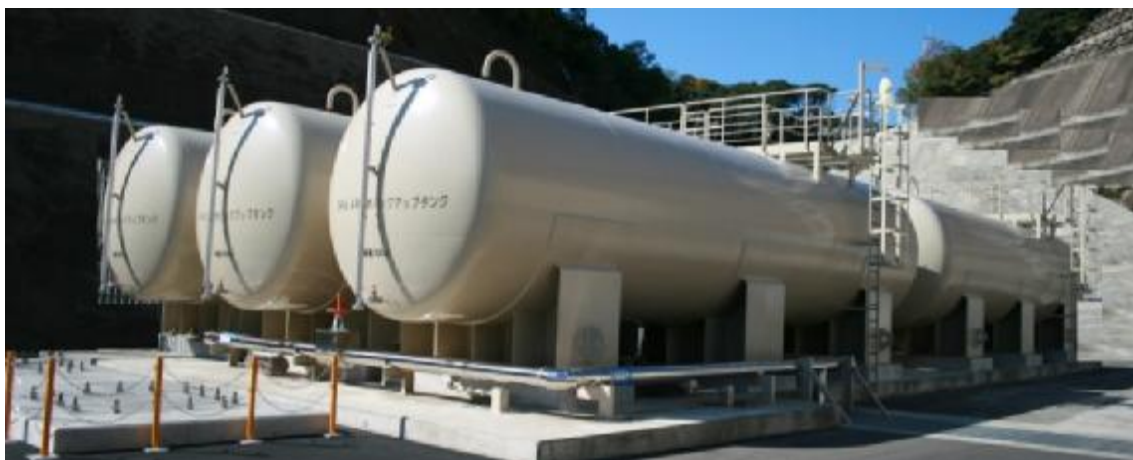
【大飯 3, 4 号機消火水系統バックアップタンク設置工事(平成 27 年 8 月完了)】
