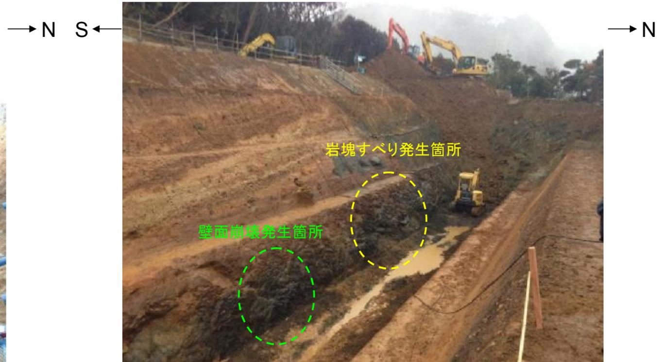
掘削状況 (H24.12.9撮影、岩塊すべり・壁面崩壊発生前)
