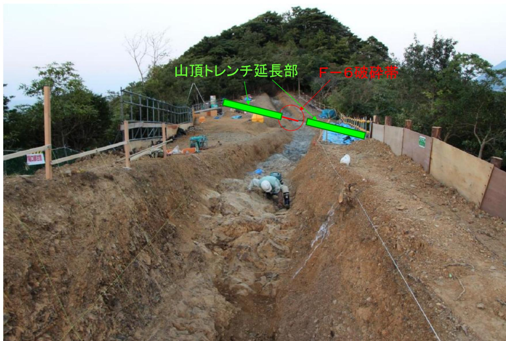
トレンチ調査で認められたF-6破碎帯の連続性に関するデータ拡充を目的として、F-6破碎帯に沿って北側へ約30m、南側へ約27m追加のトレンチ調査を実施。
