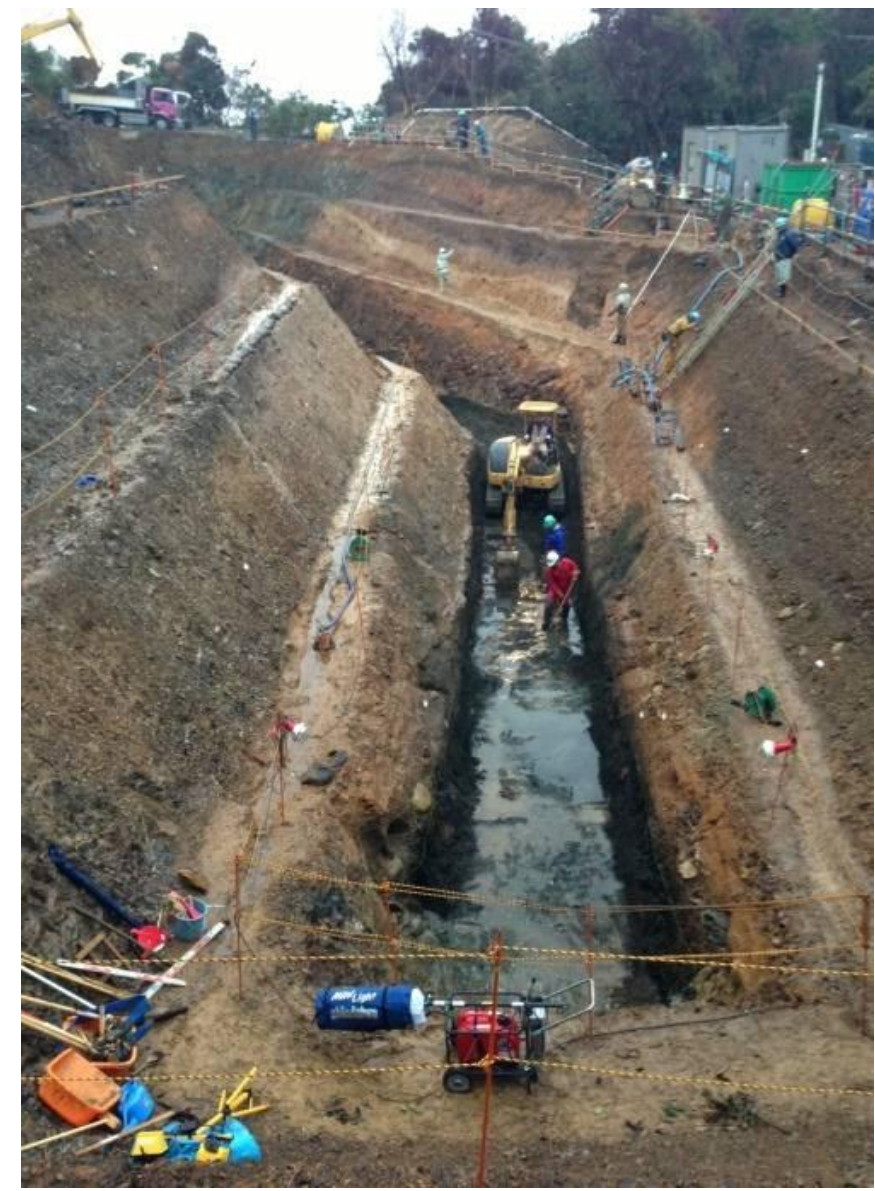
底盤深掘り状況
