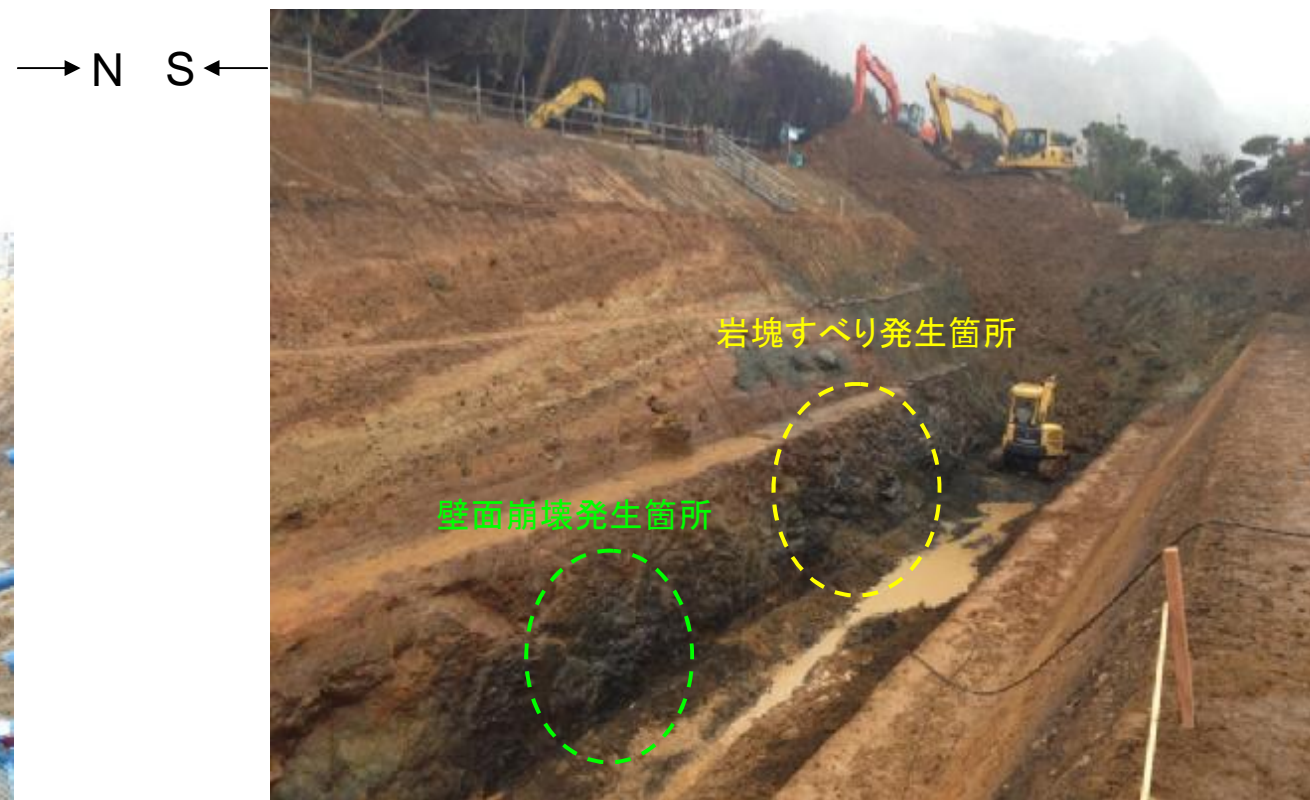
掘削状況 (H24.12.9撮影、岩塊すべり・壁面崩壊発生前)
