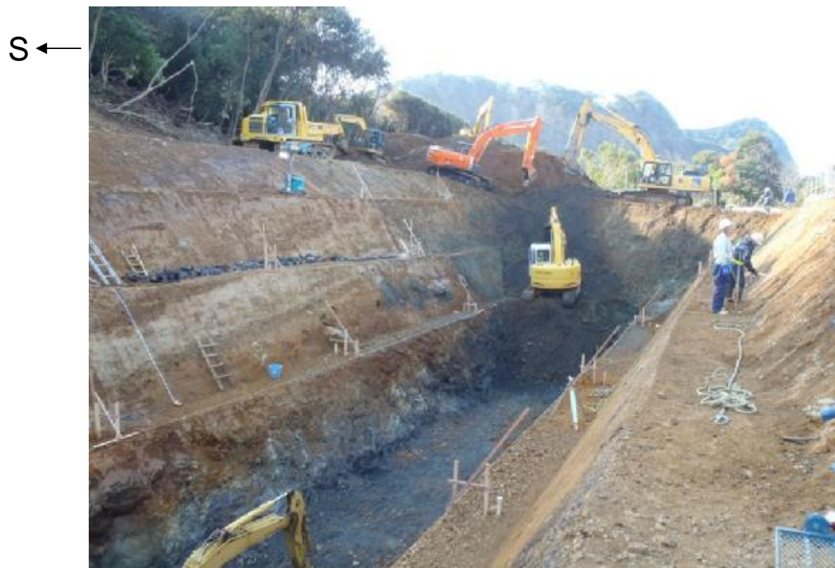
掘削状況 (H24.12.7撮影、岩塊すべり・壁面崩壊発生前)
