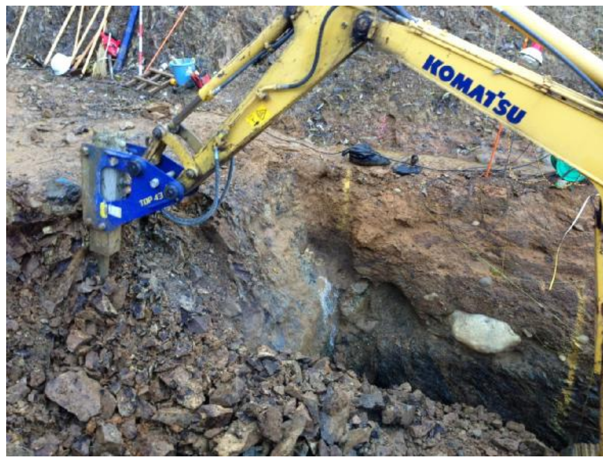
東端延長状況
