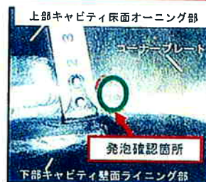
発泡確認箇所④ (コーナープレート部)
