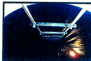
上部マンホールから見た タンク内部
