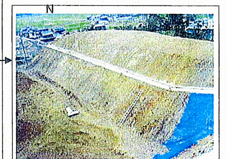
東側法面写真(長さ約70m、高さ約12m)
