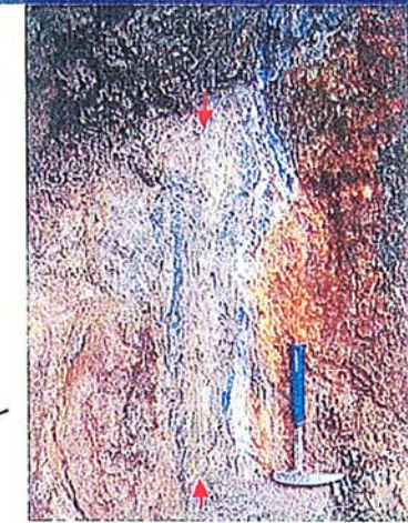
ボーリング地点南方の断層露頭
