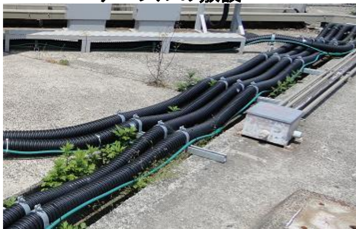
ケーブルの敷設
